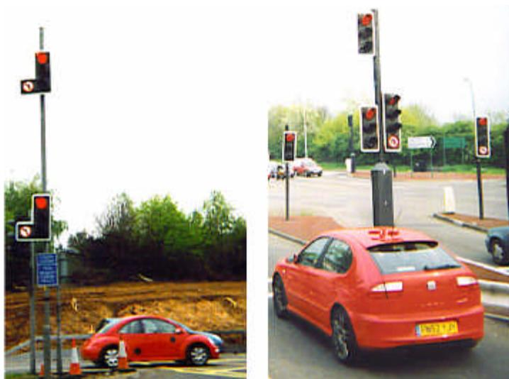
Fig. 11- Semáforos de coluna dupla em área de tráfego intenso de camiões
