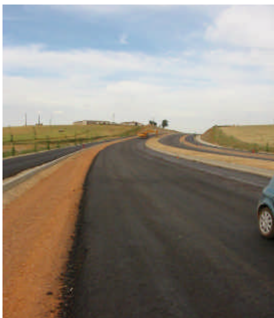
Foto 3. Ronda Norte de Cáceres. Capa de base gravaemulsión en ejecución.
